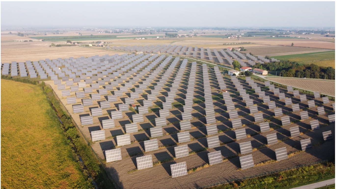
A Castelguglielmo è stato installato un impianto fotovoltaico con moduli bifacciali più efficienti.
