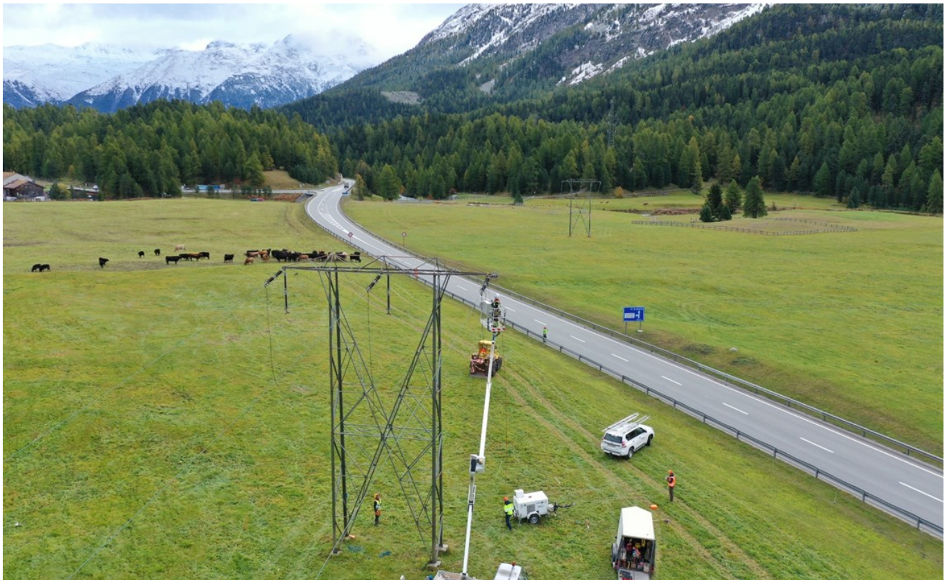
Rimozione di 13 tralicci e 71 piloni in legno dal pianoro tra Champfèr e Albanatscha, Alta Engadina.
