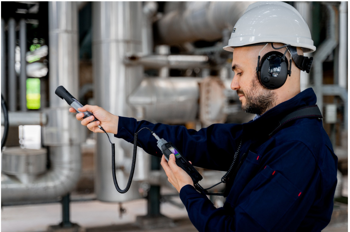
Un dipendente di Repower ascolta l'impianto ad aria compressa di un cliente per individuare eventuali perdite.
