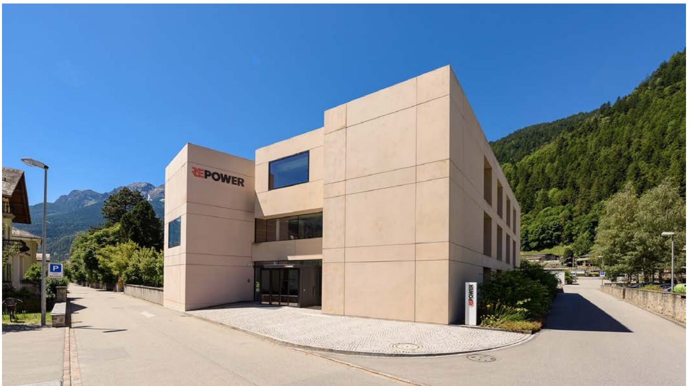
La sede centrale di Repower a Poschiavo.
