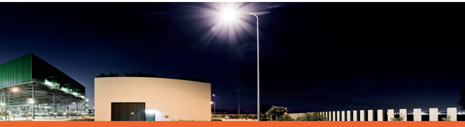
LA CENTRALE SET
